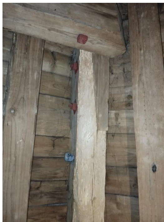
Fot.8 Widok istn. połączenia elementów krokwi /ociosanej krokwi
