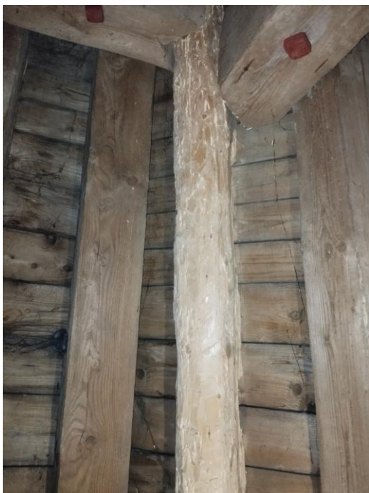
Fot.9 Widok konstrukcji dachu wieży/ociosanej krokwi
