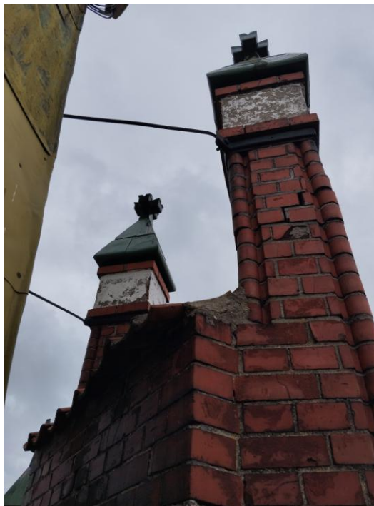
Fot.6 Widok uszkodzonej sterczyny nr 2
