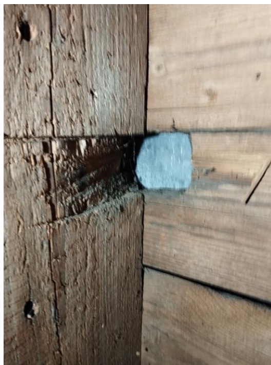
Fot.12 Widok blachy ocynkowanej przez istn. otwór w deskowaniu
