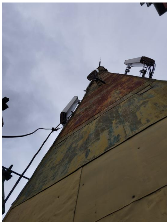
Fot.1 Widok skorodowanej blachy pokrycia dachu wieży
