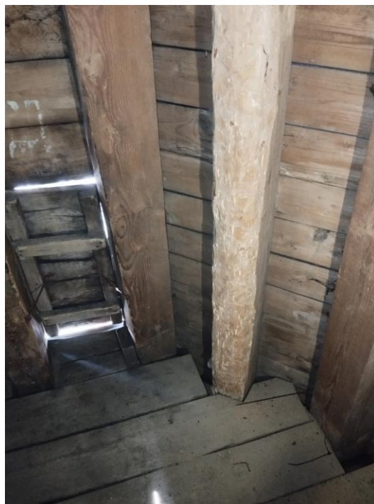
Fot.10 Widok konstrukcji dachu wieży/ociosanej krokwi
