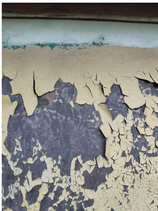
Fot.3 Widok łuszczącej się farby z blachy pokrycia dachu wieży
